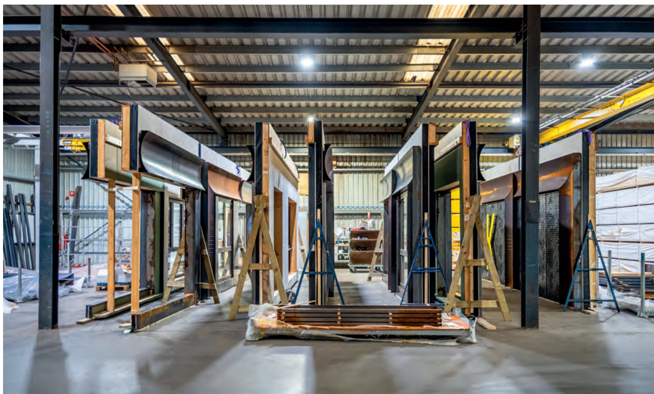
Boven: Aldowa monteerte de cortenstalen schaaldelen op de gevelelementen in de fabriek van Vront (foto: Vront).
