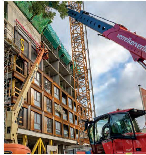
De prefab gevelelementen worden met een verreiker en hoogwerker in het werk gemonteerd.
